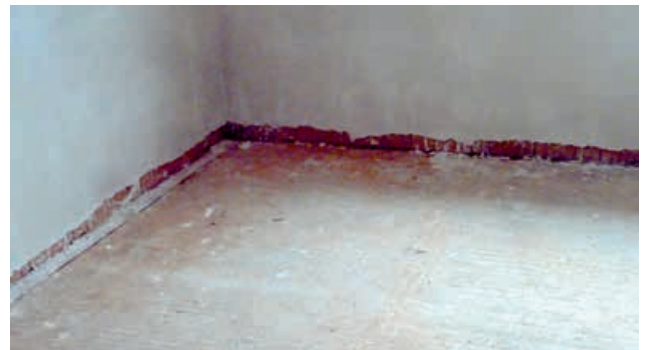
2 | Anschluss Innenputz an Bodenplatte / Betondecke: Lückenlos und fachgerecht ausgeführt?
